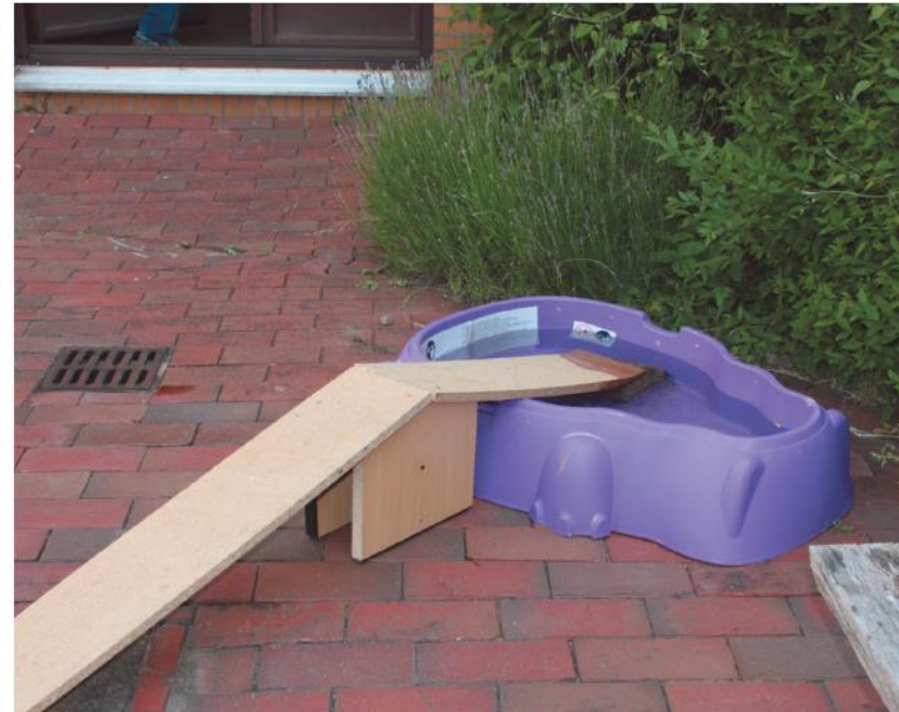
„Jeder steuert etwas bei und kümmert sich“, sagt Schulleiterin Sylvia Lindeiner. So entsteht in kürzester Zeit ein Pool mit Rampe für die Entenfamilie. FOTOS: KLEIN
