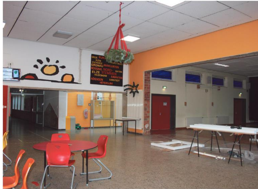
Bauarbeiten in der Marienbergsschule: Sämtliche Räume – ausgenommen ist der Turm – müssen angefasst werden, um Brandschutzauflagen auf den neuesten Stand zu bringen. Das Lehrerkollegium will diese Chance nutzen, um die Optik der Schule zu verändern. FOTOS: KLEIN
