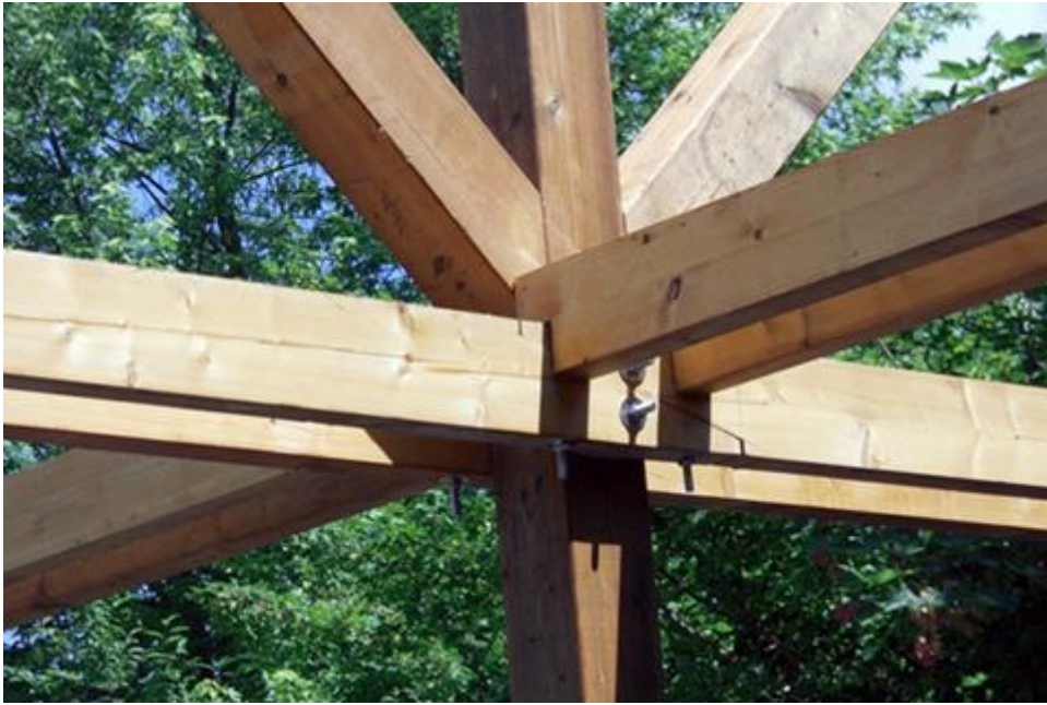
6.) Der Knotenpunkt am Mittelpfosten.
