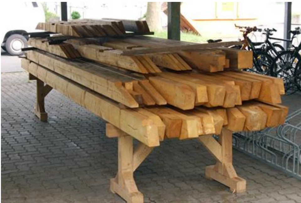
7.) Die Sparren warten auf den Einbau (frisch gestrichen von den Schülerinnen und Schülern des Technikprofils der 9. Klasse der Marienbergsschule).
