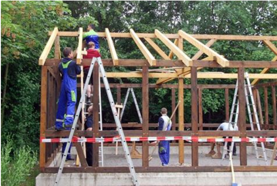
8.) Die Sparren werden aufgelegt.
