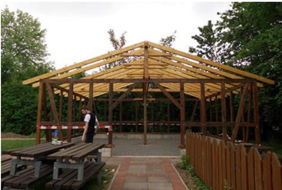
9.) Das Dach ist gerichtet ...
